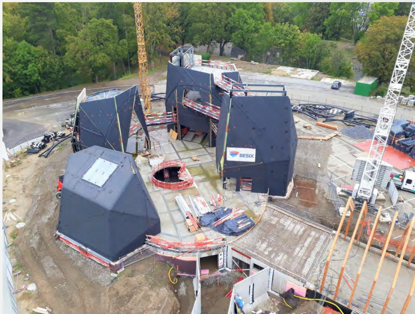
Caissons rochers 1 à 4
